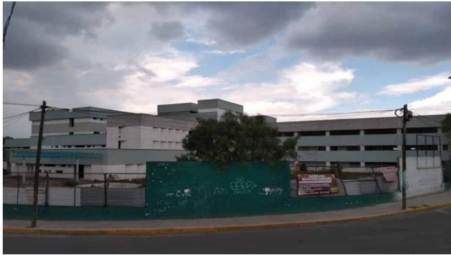
Hospital en Obra negra
